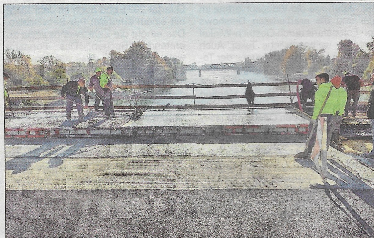
Sanierungsarbeiten an der Brücke über die Theiß.
