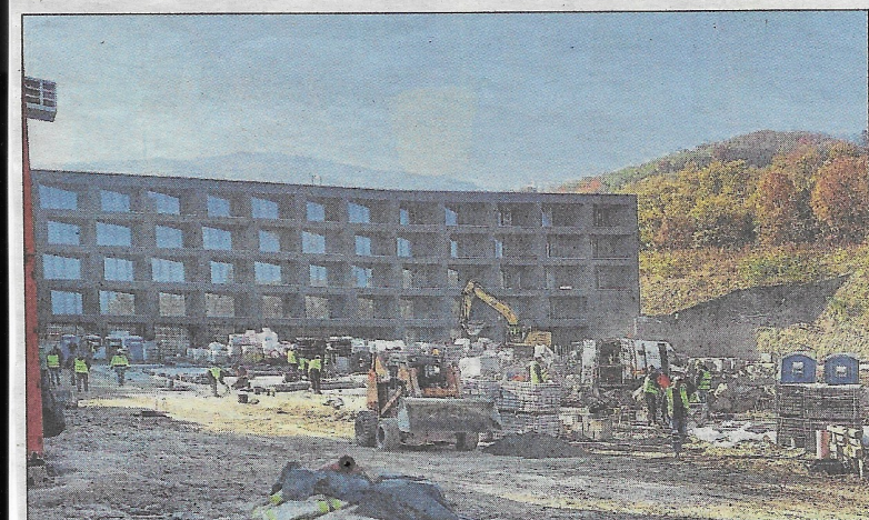
Auf der Baustelle des neuen „Grand Hotels“, im Hintergrund der Kopasz-Berg mit den Sendemast.
